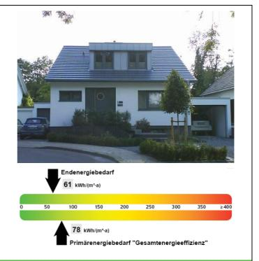
Besonderheit: Nach der Sanierung und Erweiterung des Gebäudes konnte durch eine umfassende Wärmedämmung und Erneuerung de Haustechnik das Niveau eines KfW-Effizienzhaus 100 im Bestand erreicht werden. Als Haustechnik wurde eine Erdgas-Brennwertheizung mit einer thermischen Solaranlage zur
